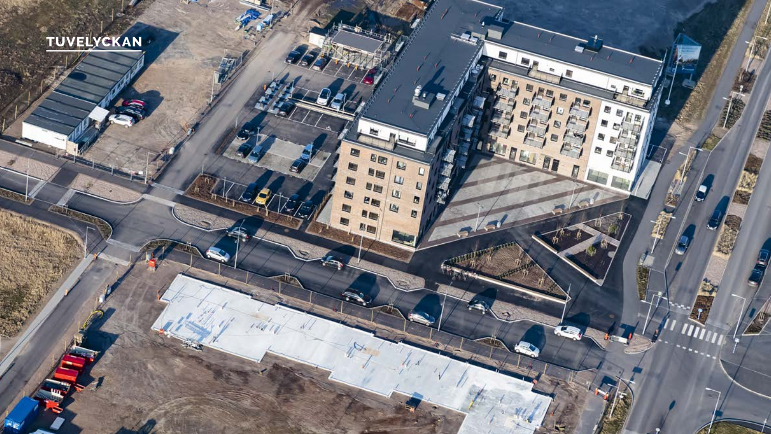
Torghuset färdigställdes 2018 och inrymmer 72 hyreslägenheter och fyra butikslokaler. Bredvid byggs Stationshuset med 80 lägenheter.
